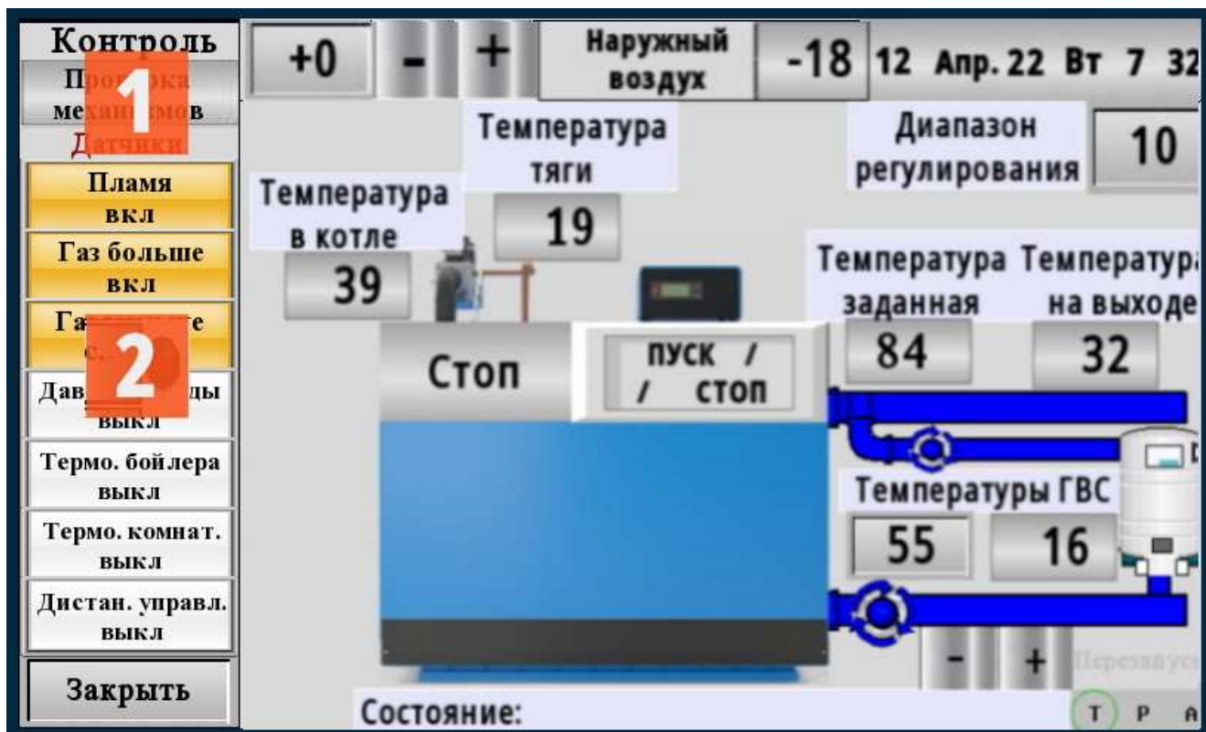
Рис. 19 Проверка состояния датчиков
